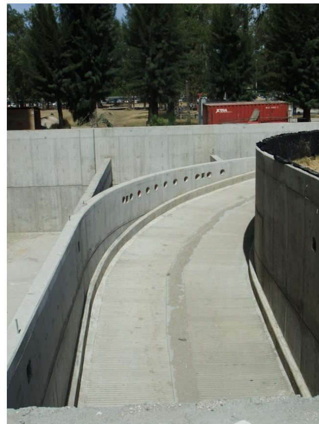
Rampa de acceso al estacionamiento
